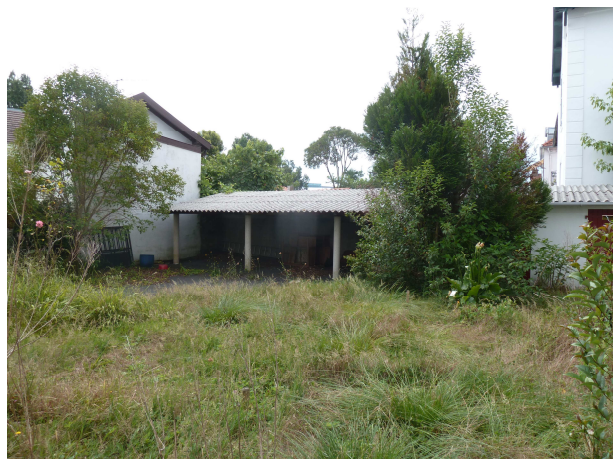
Abri / garage sur jardin (côté Est)
