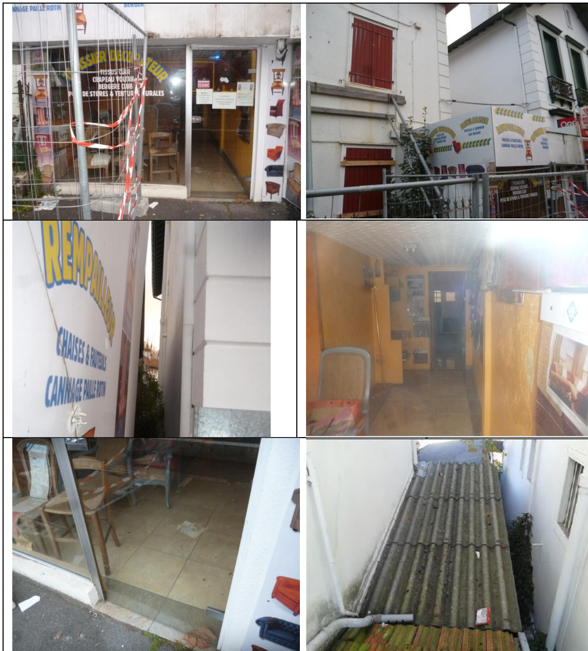
Figure 14 : Vues du local commercial
