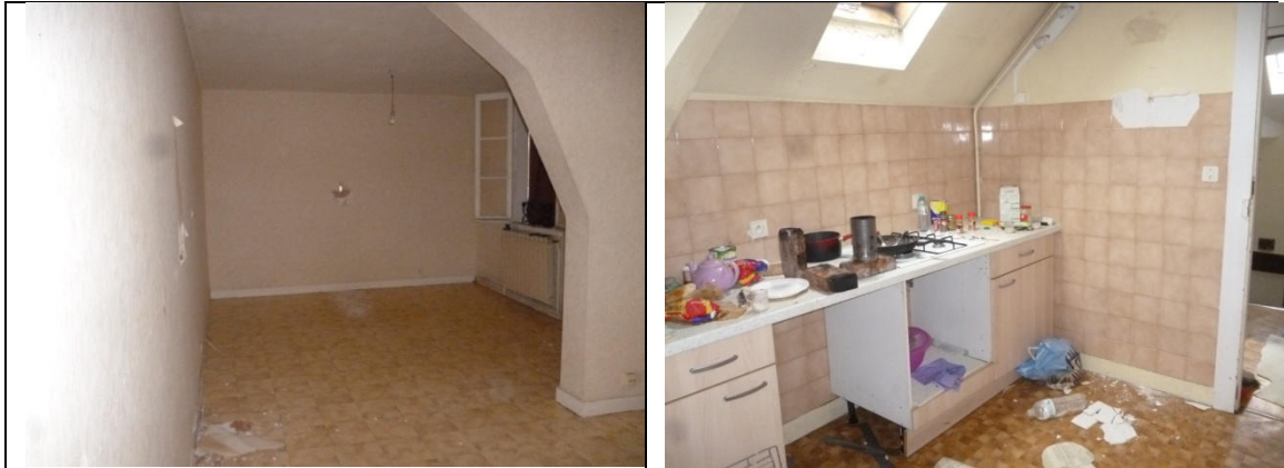
Figure 11 : Vues intérieures de la maison d'habitation
