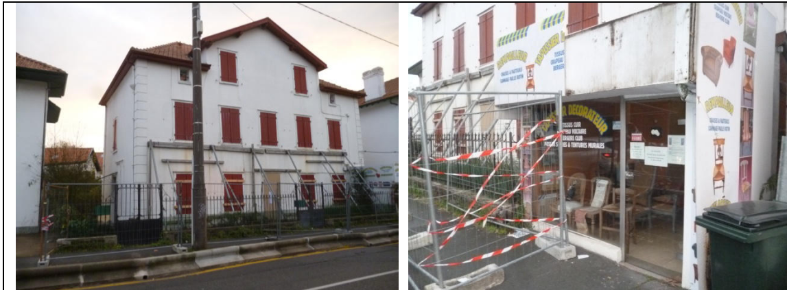
Figure 3 : Vues de l'habitation et du local commercial depuis l'avenue de Martres
