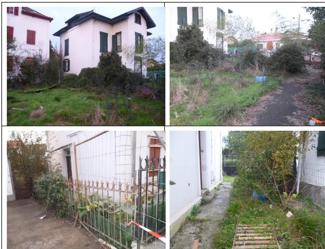
Figure 7 : Vues de la clôture au nord
